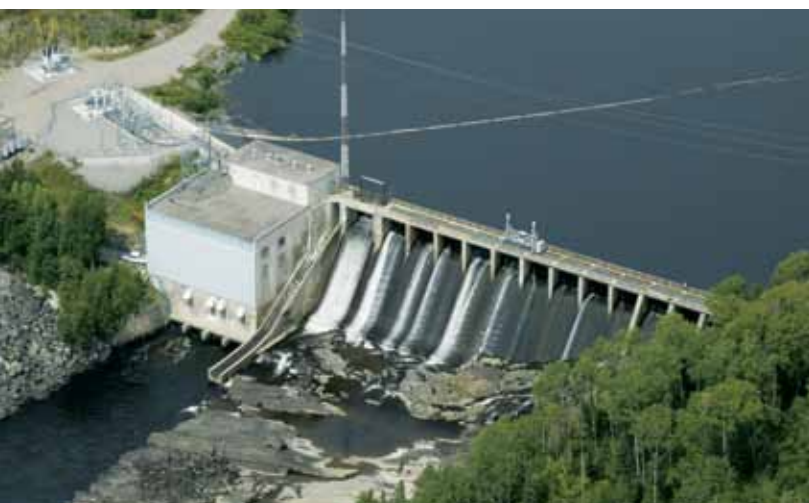
Centrale électrique de Sturgeon Falls, en Ontario
